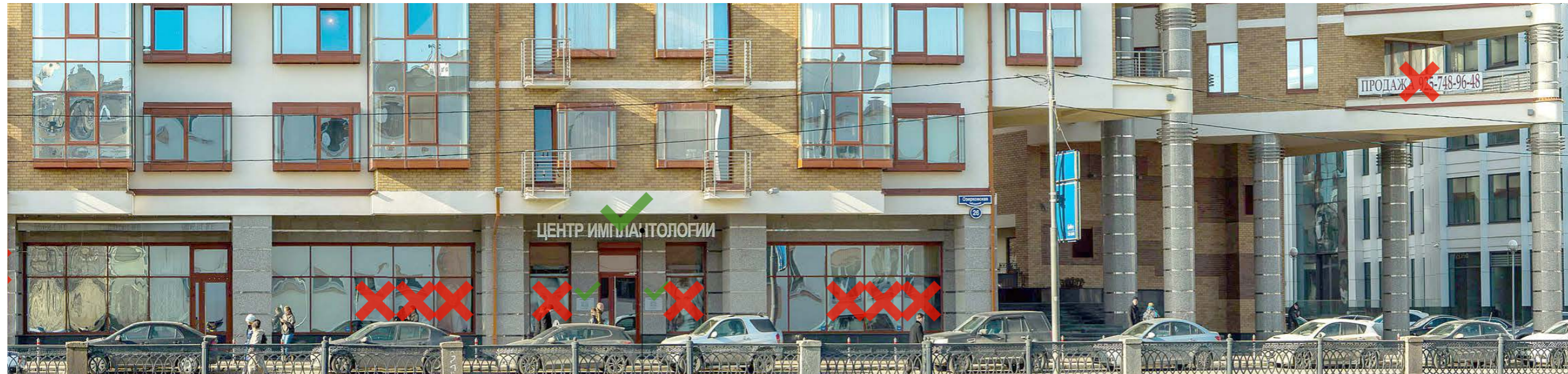
вывеска размещается между колоннами
