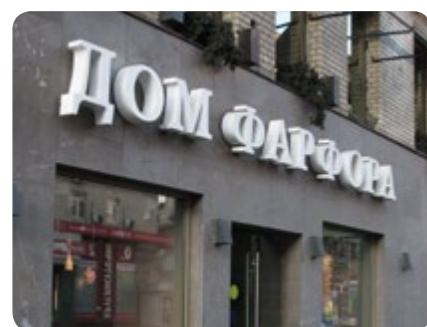
Рис. 1-1. Настенная вывеска из отдельно стоящих букв без подложки
