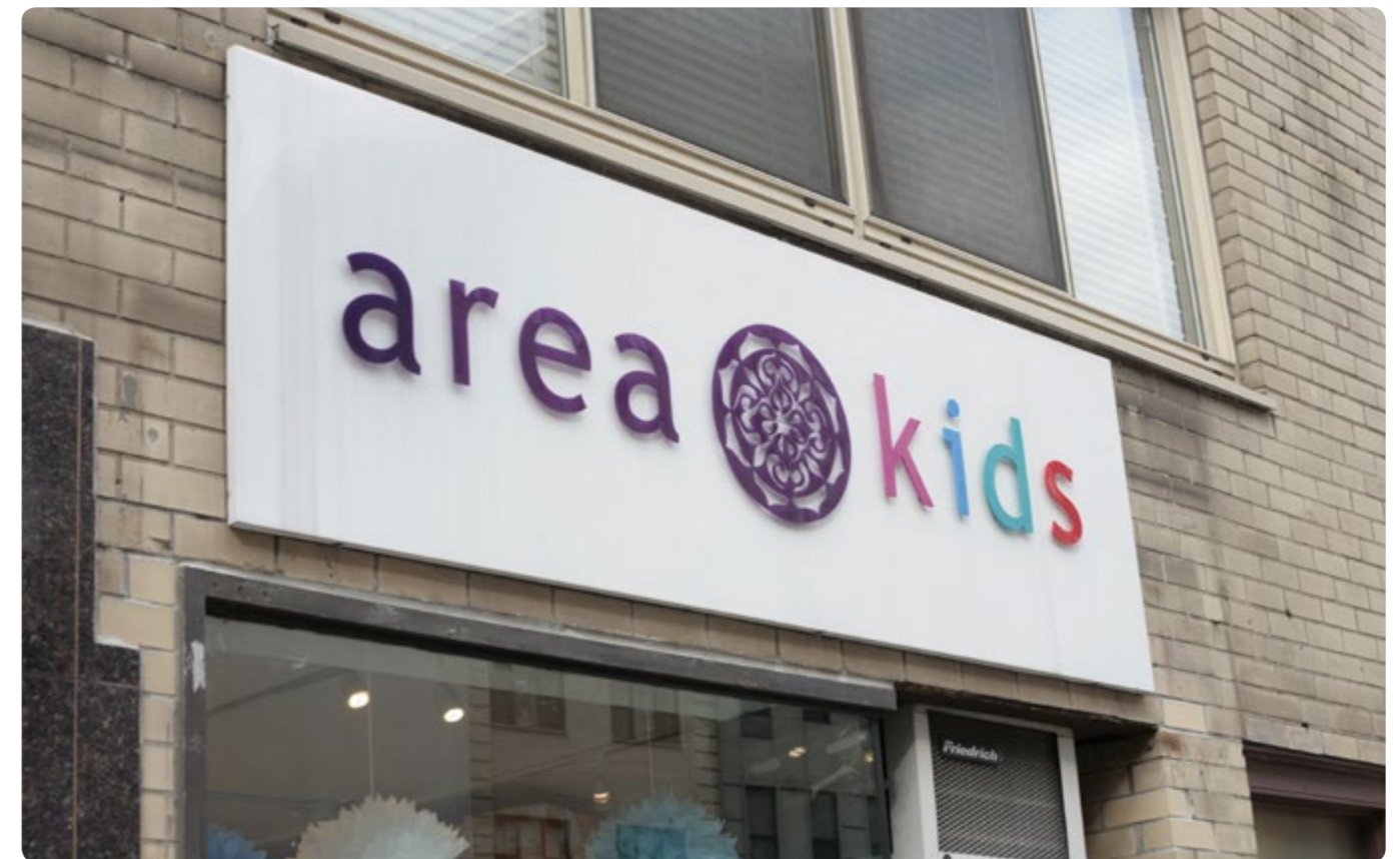
Рис. 2-17. Плоские буквы на подложке почти вплотную к фасаду
