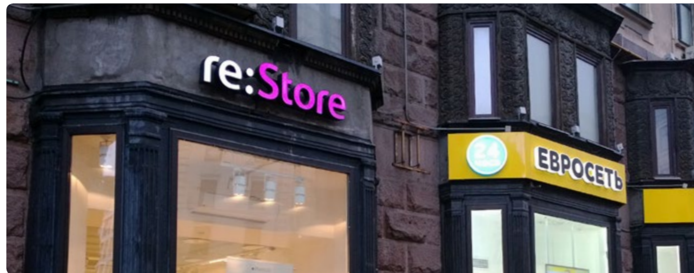
Рис. 2-20. Вывеска без подложки (слева) меньше портит облик здания
