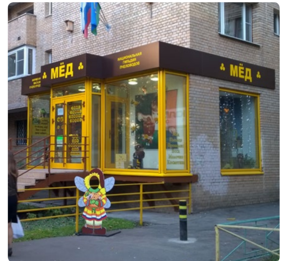
Рис. 2-87. Пристроенный вход на первый этаж
