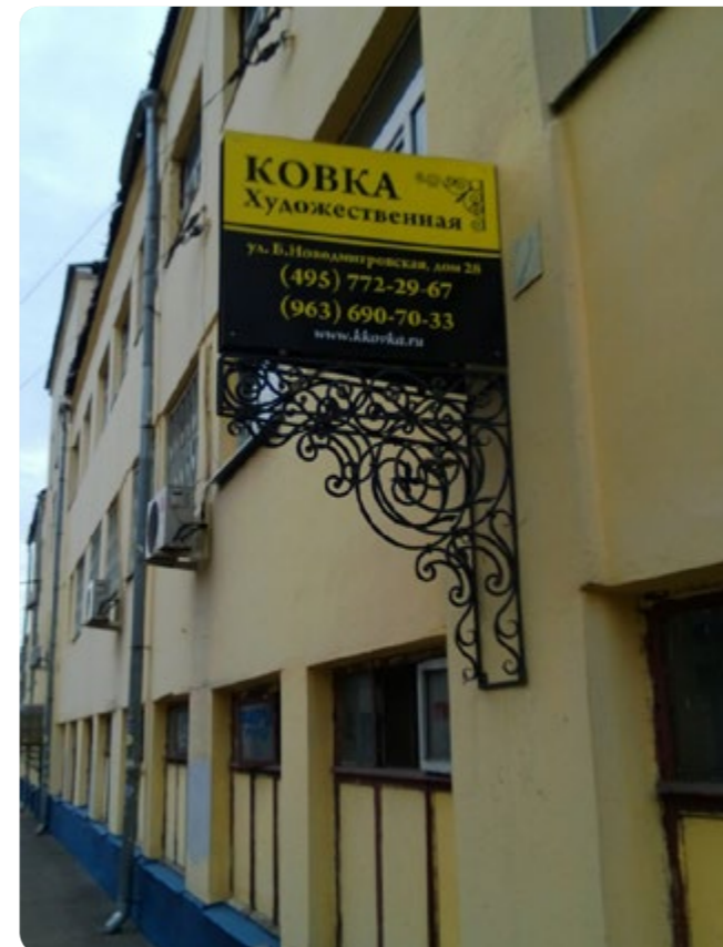
Рис. 2-52. Декорированная консоль не соответствует облику здания
