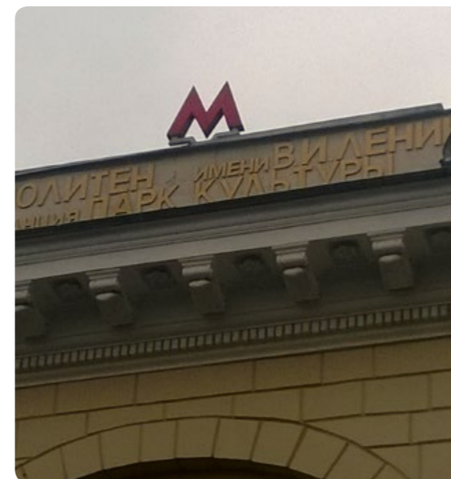
Рис. 2-75. Вывеска с логотипом метрополитена на крыше
