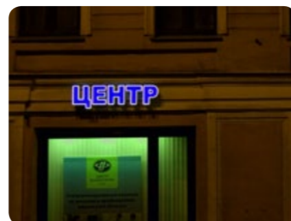
Рис. 4-3. Настенная вывеска из объемных букв с внутренним подсветом без подложки
