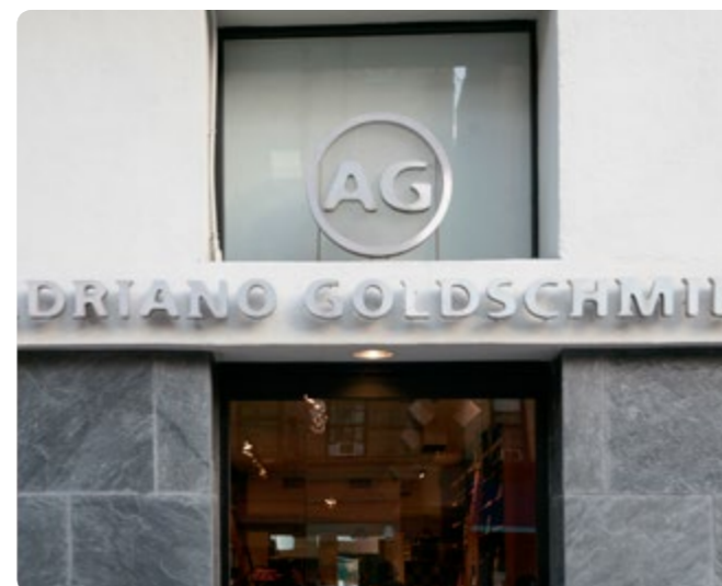
Рис. 2-12. Объемные буквы отнесены от стены
