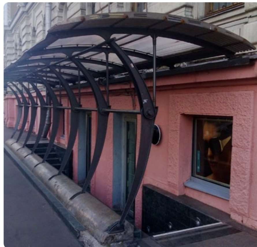
Рис. 2-86. Вход в цокольный этаж с козырьком
