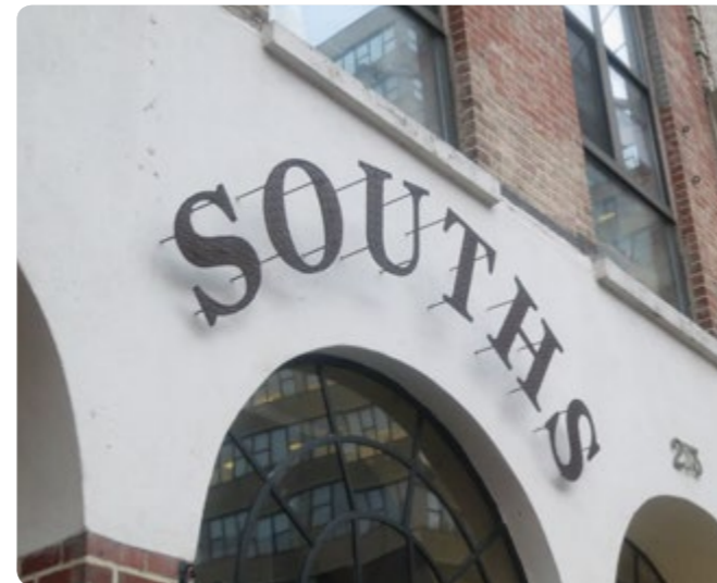
Рис. 2-10. Плоские буквы отнесены от стены
