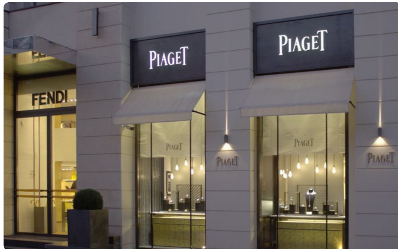
Рис. 2-28. Световые короба выровнены по ширине оконных проемов
