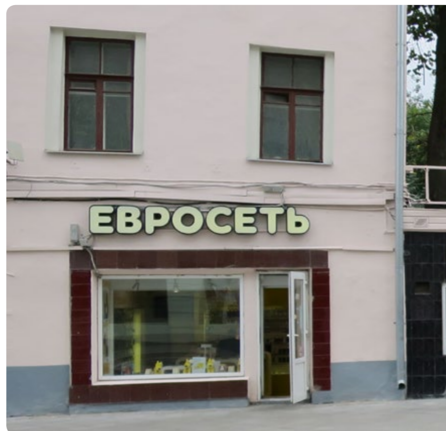
Рис. 3-2. Допустимо: светлая вывеска не нарушила цельность фасада, но читается плохо
